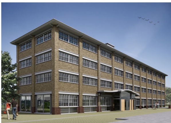
Foto: ACEC gebouw
